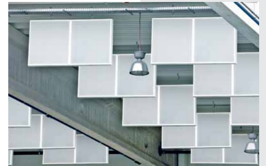
Fabrica optimizada acústicamente en la que se han dispuesto celdillas de silenciador TROX
