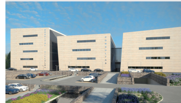
Con más de 55.600 m 2 de terreno cedidos por el Ayuntamiento de Collado Villalba. Los elementos de difusión y distribución de aire persiguen recrear ambientes confortables y eficientes para los usuarios y el personal sanitario, en un proyecto de construcción moderno y funcional.
