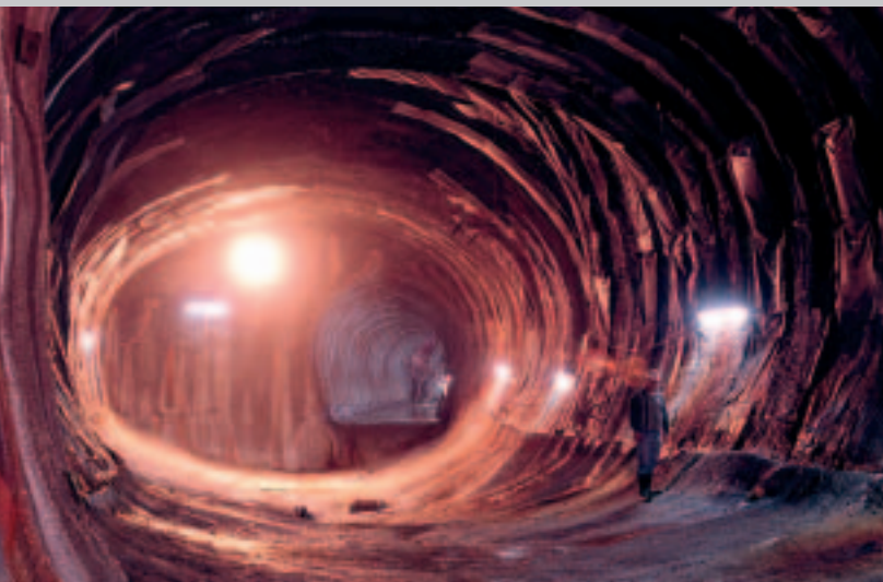
Túnel de metro en Copenhague
