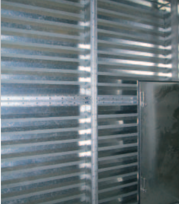
Conjunto de compuertas multilamas a base de módulos para instalación en una central de ventilación
