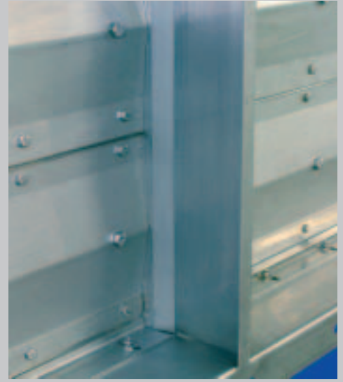
Vista del travesaño central y junta metálica de estanqueidad
