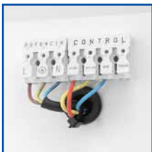
Detalle caja de bornas en unidades fancoil
