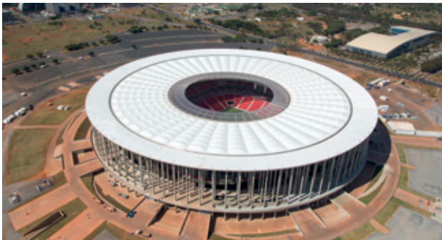
Estádio Nacional, Brasília: Sistemas de ventilación y tratamiento de aire de TROX en el nuevo estadio de Brasil
